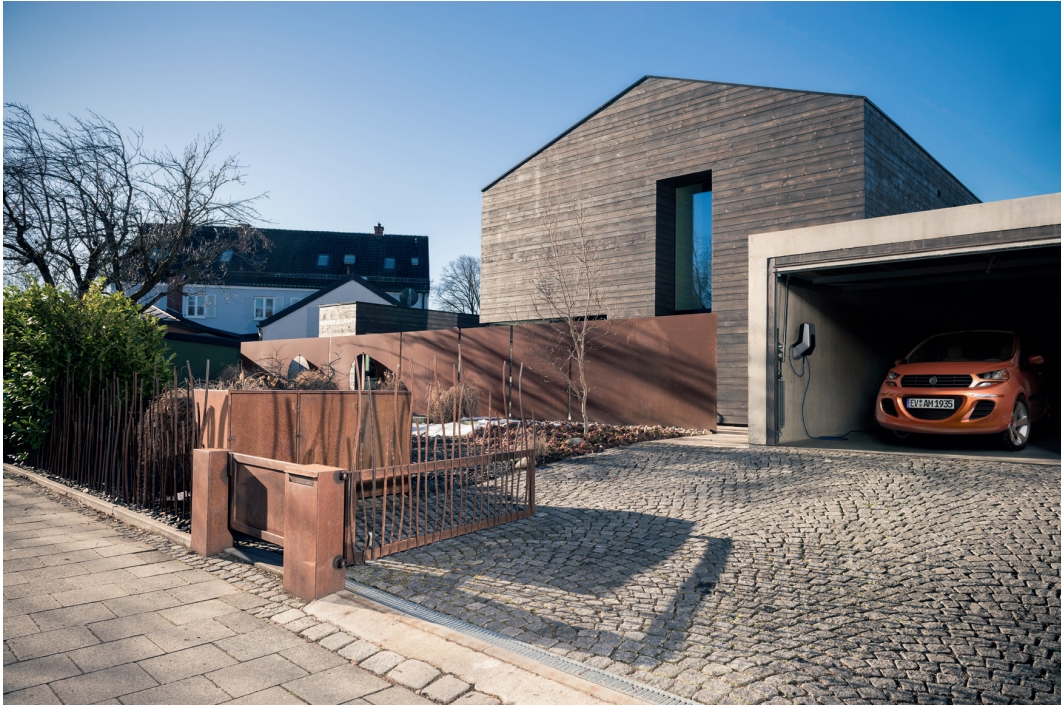
Bild 2: Ladeeinrichtung für Elektrofahrzeuge auf einem privaten Grundstück
